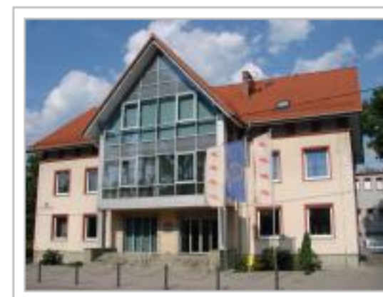
Spółdzielnia DOMENA - budynek 1
